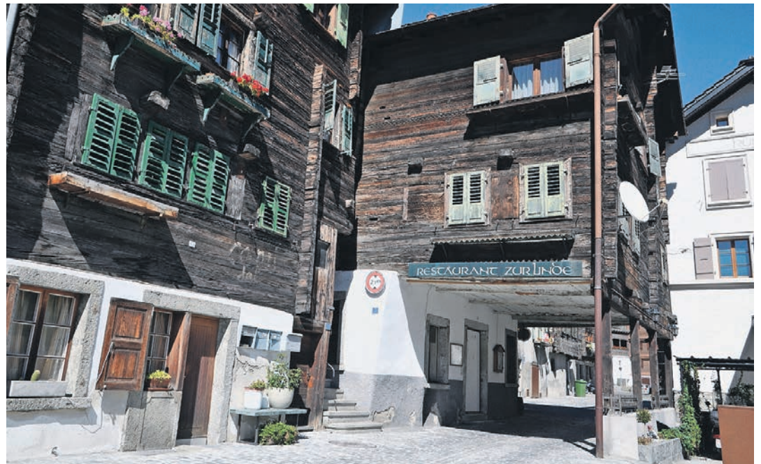
Nächstes Jahr soll das Restaurant zur Linde den Betrieb wieder aufnehmen.
