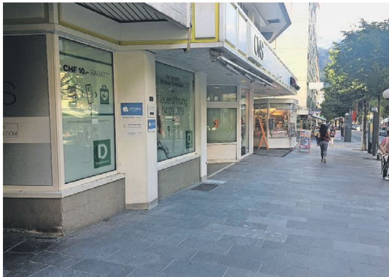
Derzeit baut Dosenbach seine künftige Filiale an der Bahnhofstrasse um.
