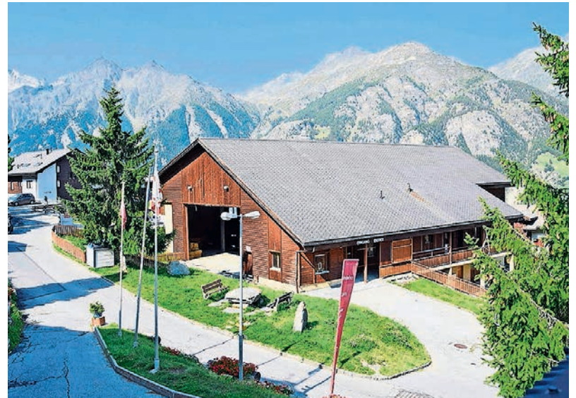
Die leer stehende Talstation der Seetalhornbahn soll zu einem Hotelgrossojekt umgestaltet werden.
