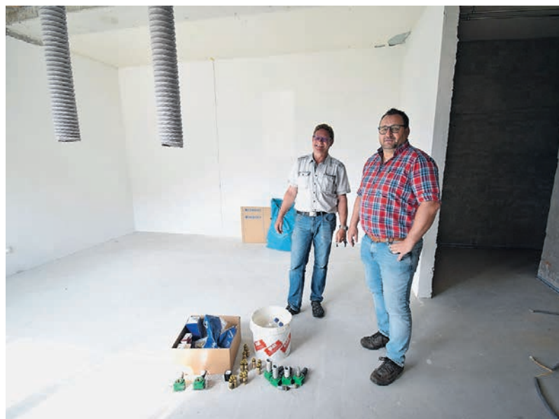
Zuversichtlich: Gemeinderat Arno Brantschen (l.) und Gemeindepräsident René Abgottspon auf der Baustelle der MZH Baltschieder.
