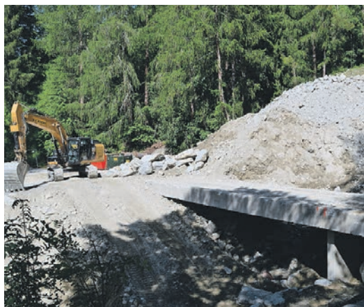
Die Brücke in Steinhaus wird instand gesetzt.
