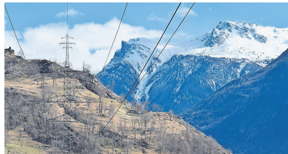
Im Goms entsteht eine neue Stromleitung. Foto zvg
