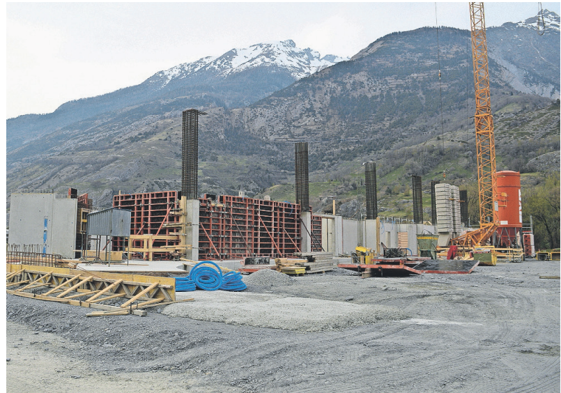
An der neuen Rarner Eishalle wird derzeit kräftig gebaut.
